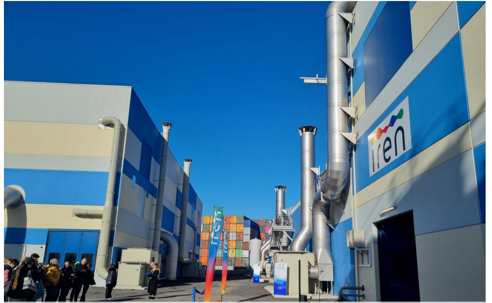
Il depuratore avrà una capacità di trattamento delle acque reflue per una popolazione di 250.000 abitanti, cui corrisponde una portata di circa 50.000 mc/giorno, con un incremento di capacità pari a quasi il 40% in più rispetto al precedente impianto di Valpolcevera
